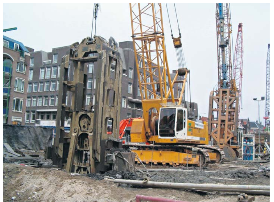
De bouwput die de Noord-Zuidlijn oplevert.
