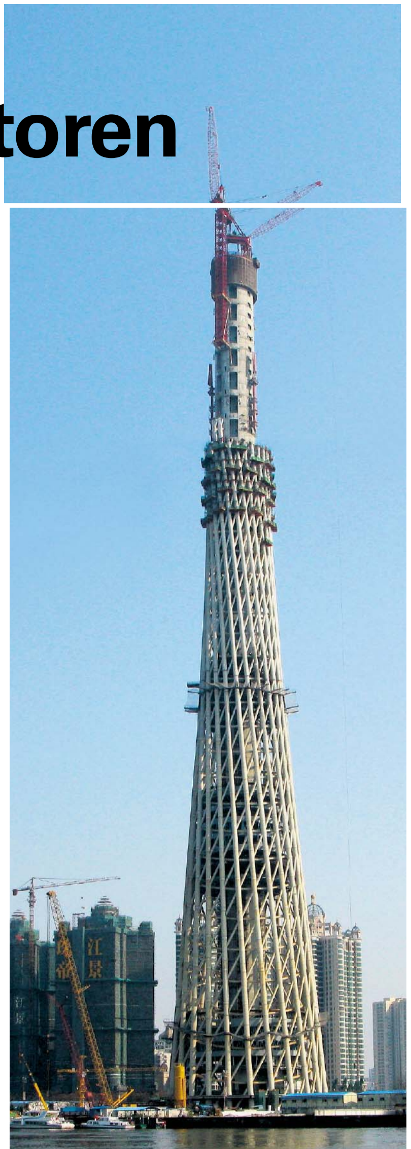
De televisietoren van Guangzhou in aanbouw Foto's Information Based
